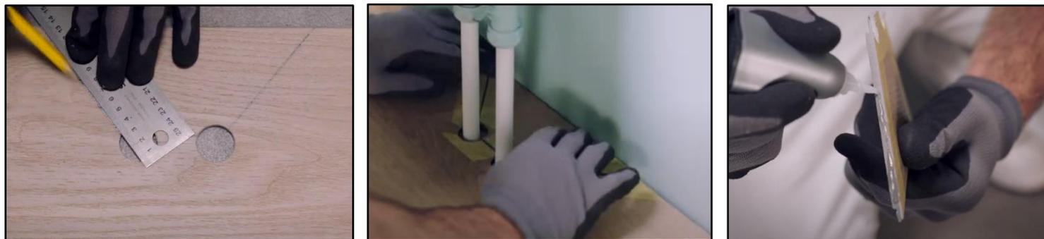
Bei einem Doppelrohr bohren Sie an allen markierten Stellen ein Loch mit demselben Durchmesser wie die Rohre, wobei Sie 15 mm abzählen. Wenn sich die Rohre an der Längsseite der Fliese befinden, machen Sie einen 45-Grad-Schnitt von jedem Loch zur Seite der Fliese.
